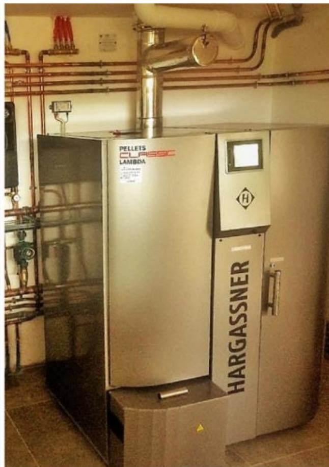
*A Cénac-et-Saint-Julien en Dordogne nous avons remplacé une chaudière fioul par une chaudière à granulé de bois Hargassner. Ici la chaudière assure le chauffage et l'eau chaude sanitaire de l'habitation.*
