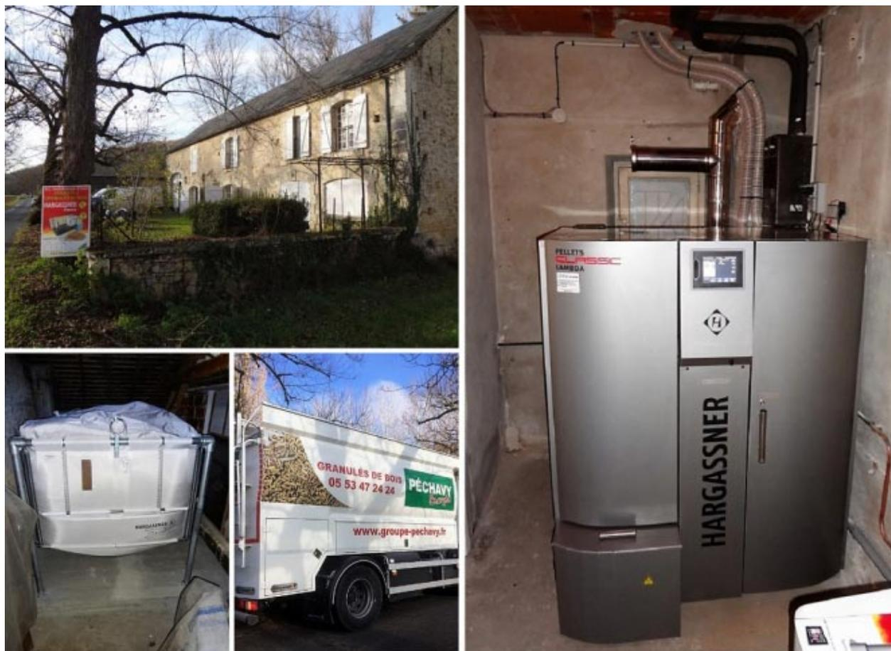
*Remplacement d'une chaudière fioul par une chaudière à granulés de bois HARGASSNER Classic Lambda de 25 kw - Pilotage à distance via une passerelle internet et une application gratuite Hargassner - Un silo de stockage textile d'une capacité de 6 tonnes alimenté par la société Pechavy énergie a été mis en place pour couvrir les besoins annuel*
